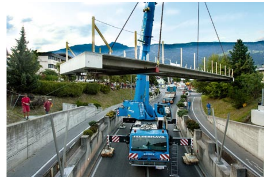
Spektakuläre Einhebung der neuen Rad- und Fußgängerbrücke über der Amlacher Straße
