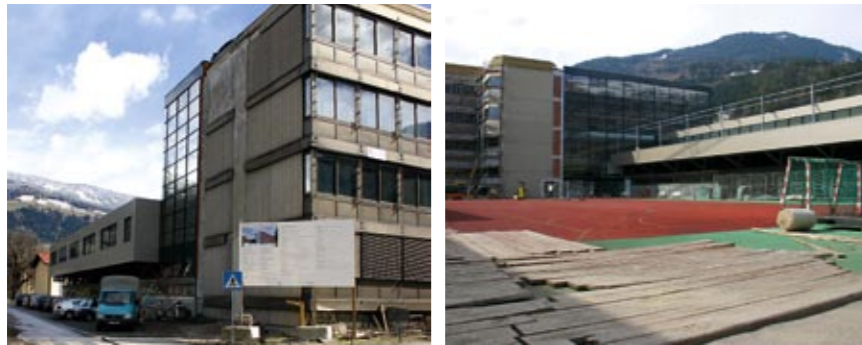
Um- und Ausbau des Bundesschulzentrums in der Weidengasse
